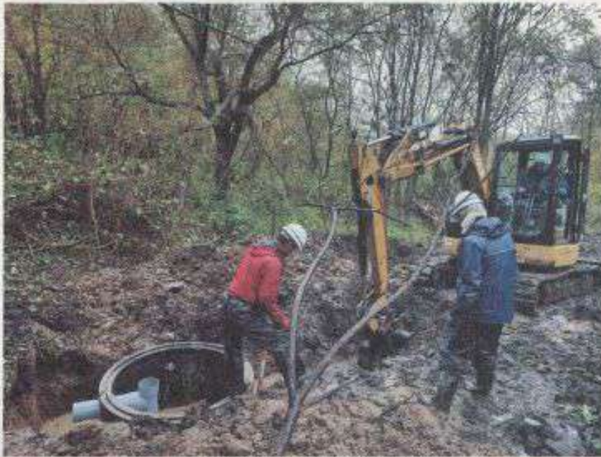
大和牧場での給水取水施設設置工事
